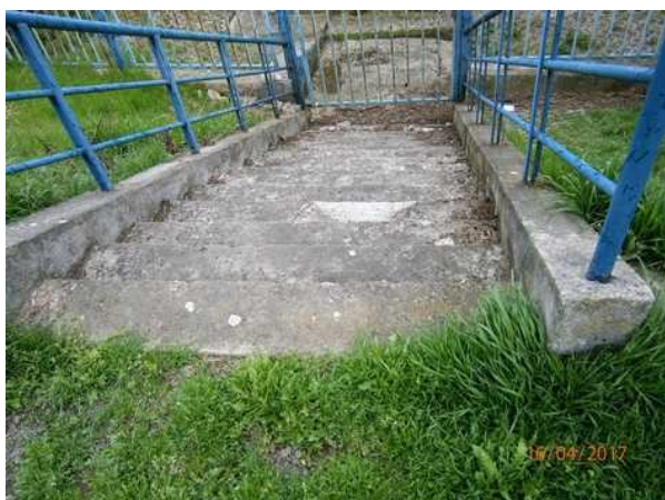
7. Pohled od S strany na bet. schodiště pro přístup z ul. Vilová k regulační stanici plynu. Schodiště je na oceňované parcele
