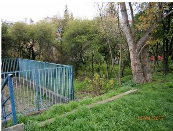
1. Pohled od SV na okraj oplocené par. č. 4071/3, kde je regulační stanice plynu a dále par. č. 4071/1 s porosty
